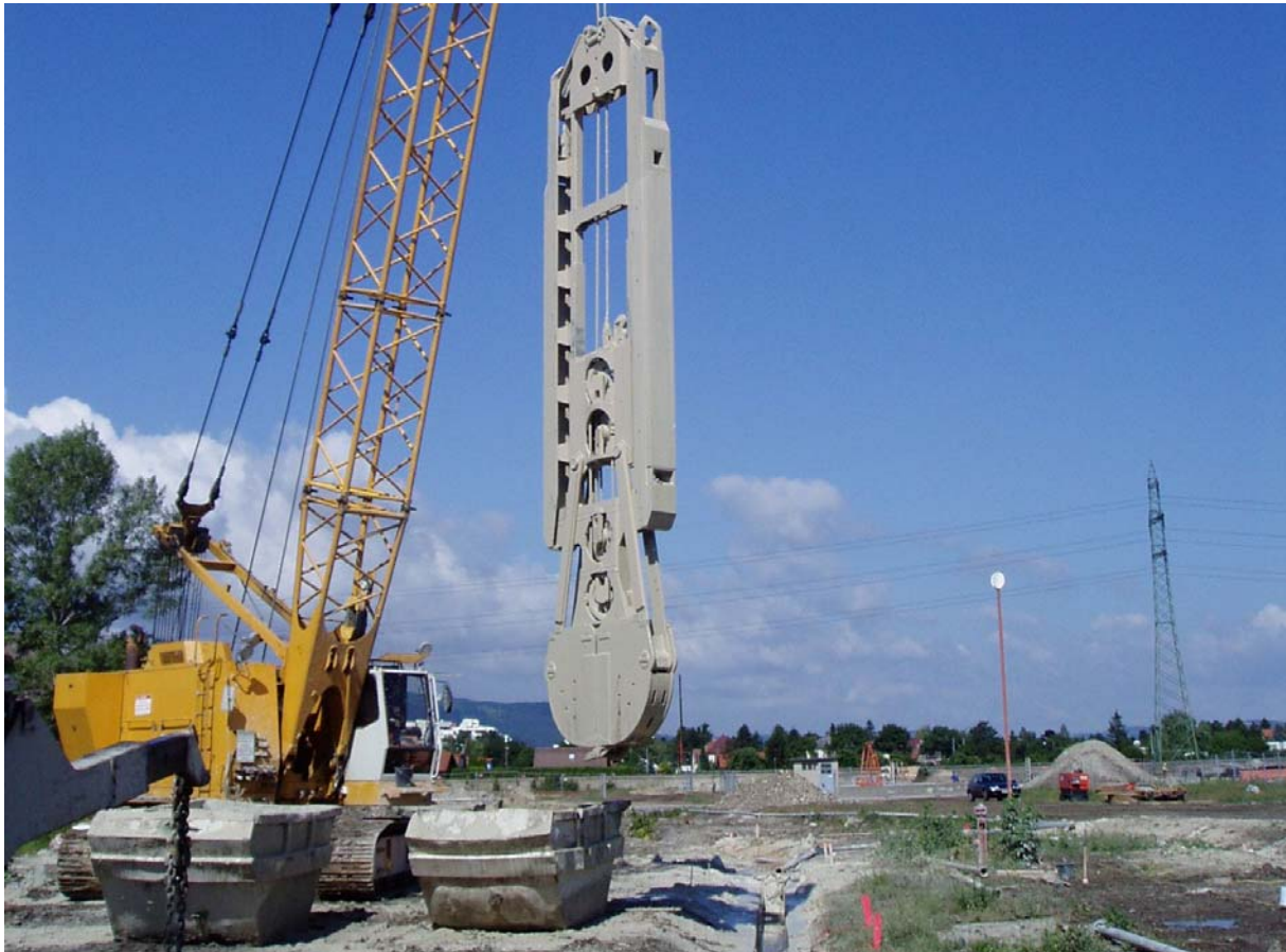
Abb. 1: Altstandort "Gaswerk Leopoldau" - Herstellung der Dichtwand
