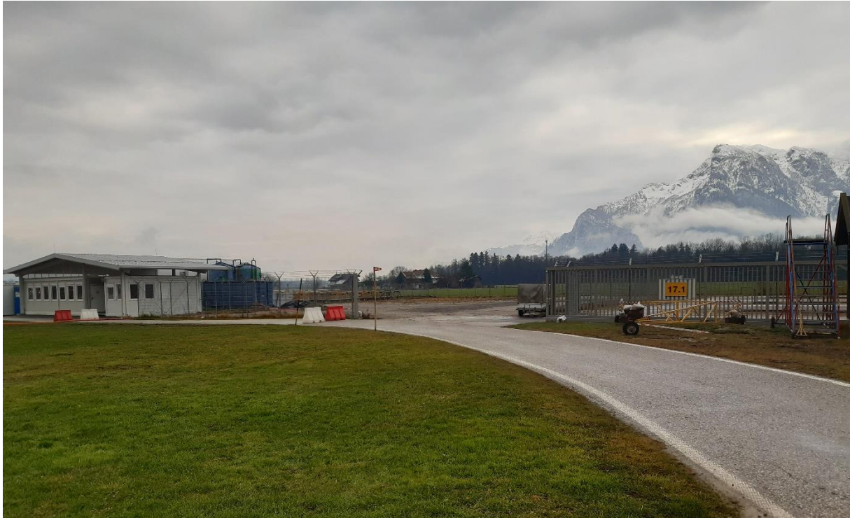
Flughafen Salzburg – Feuerlöschübungsgelände (© Umweltbundesamt)
