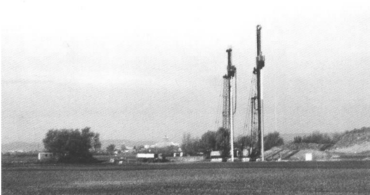
Abb. 1: Herstellung Dichtwandumschließung Altablagerung "Spitzau"
