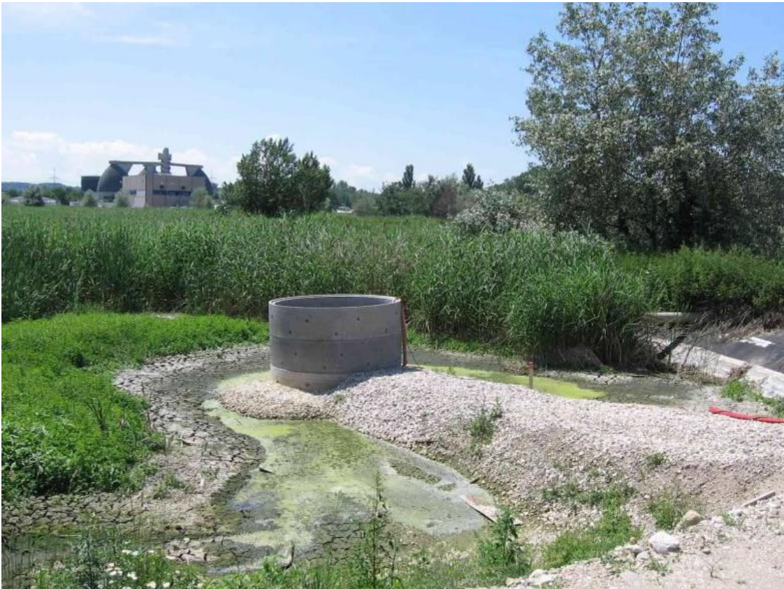
Pumpschacht Niederschlagswasser L-Teich (2010)
