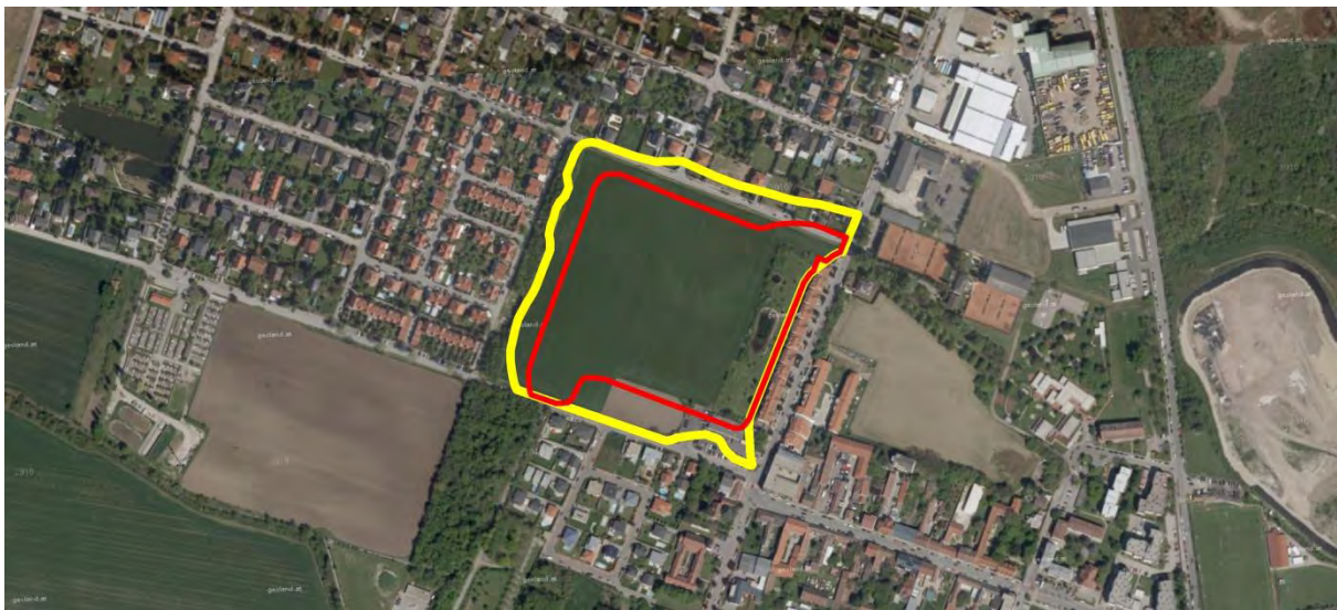
Abb. 4: Lage der Altablagerung (gelb) und der Altlast (rot) im Luftbild (Befliegung 13.6.2013)
