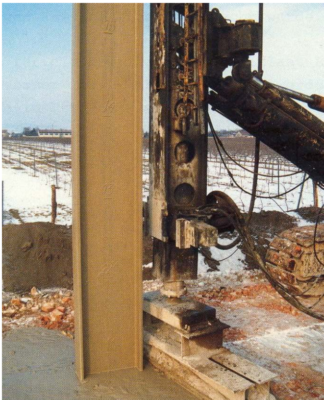
Abb. 1: Herstellung der Rüttelschmalwand
