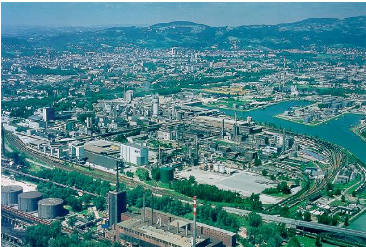
Abbildung 1: Überblick über den Altstandort – im Vordergrund die Kokerei der VOEST-Alpine Stahl Linz; im Hintergrund die Stadt Linz und der Hafen
