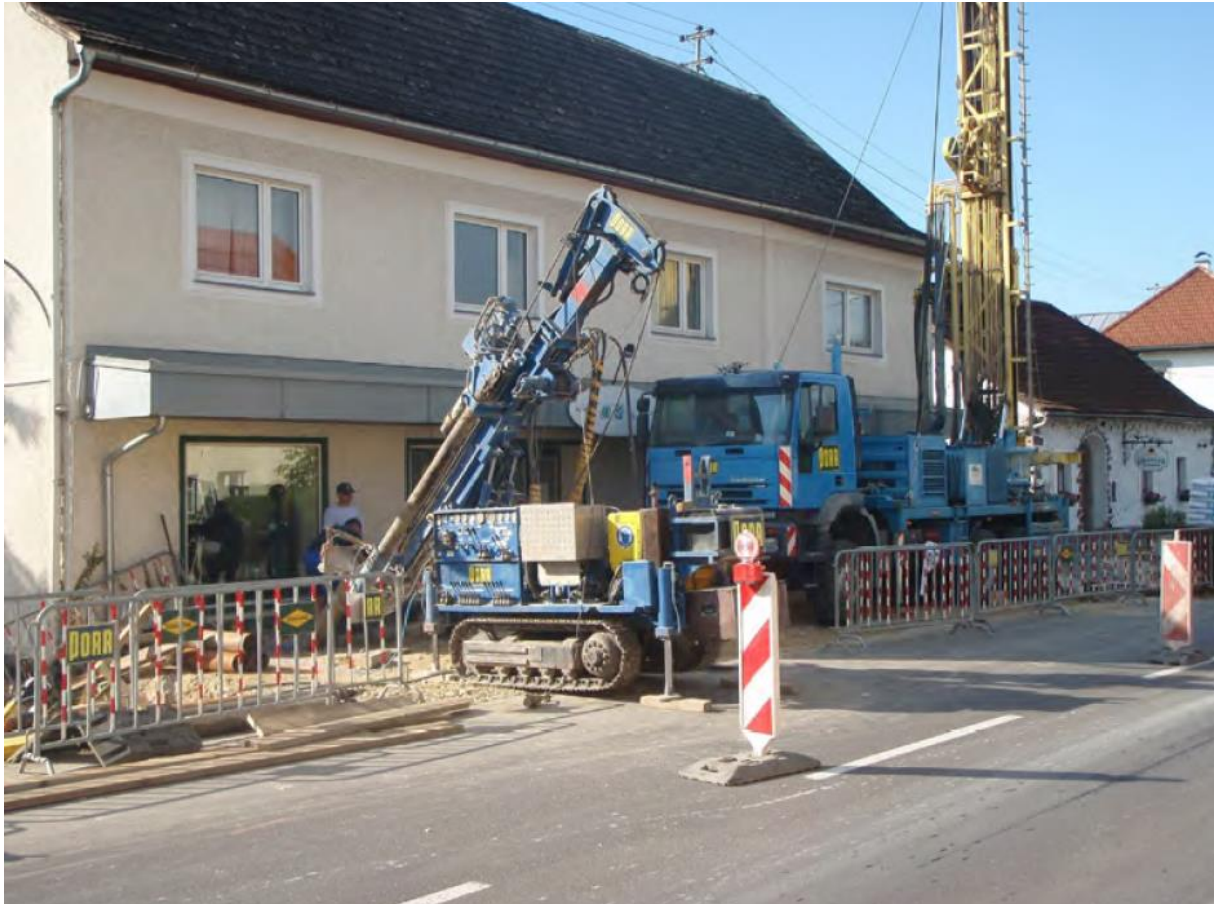
Bohrarbeiten zur Errichtung der Bodenluftabsaugung und eines Sperrbrunnens (2011)
