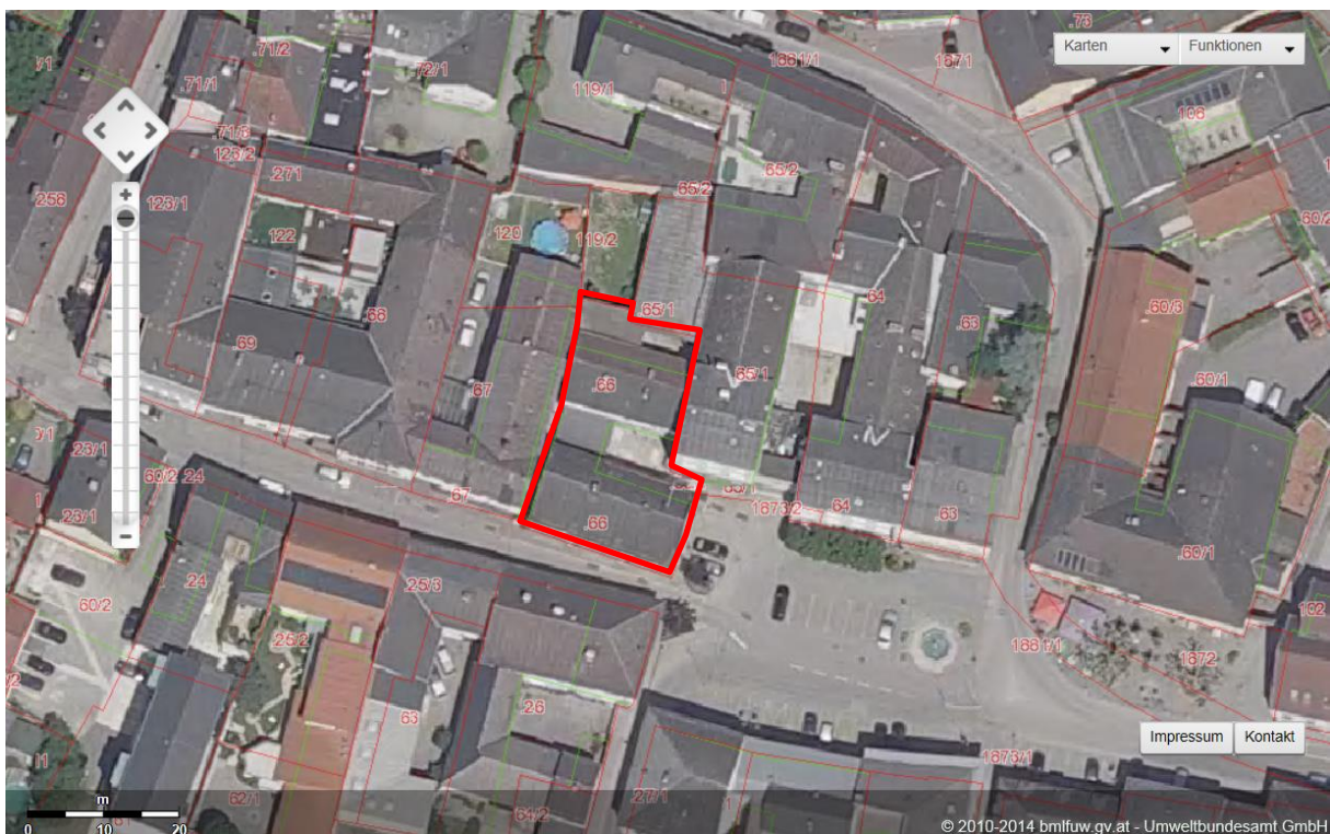
Abb.3: Luftbild „Putzerei Lengauer“ (Befliegung 2010)
