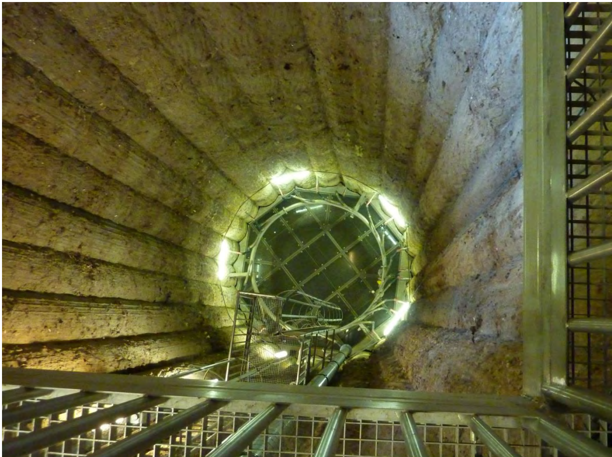
Abb. 1: Altlast "Rudolf Zeller Gasse" – Bohrpfahlschacht
