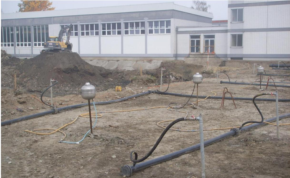
Aushubmaßnahmen mit In-situ-Aerobisierung zur Geruchsminimierung
